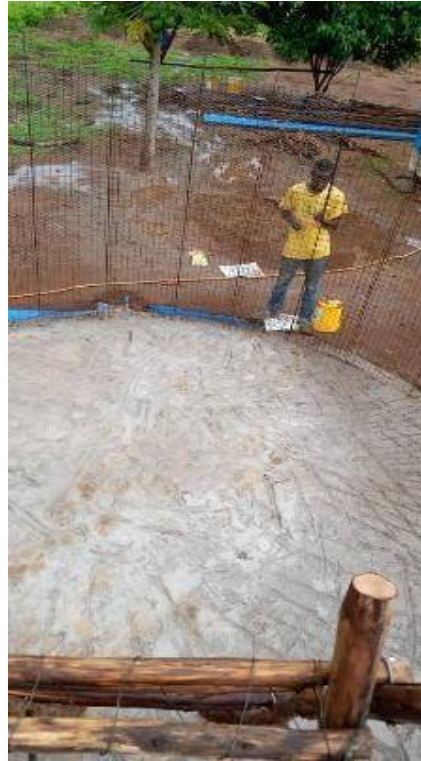
Boden des Tanks
