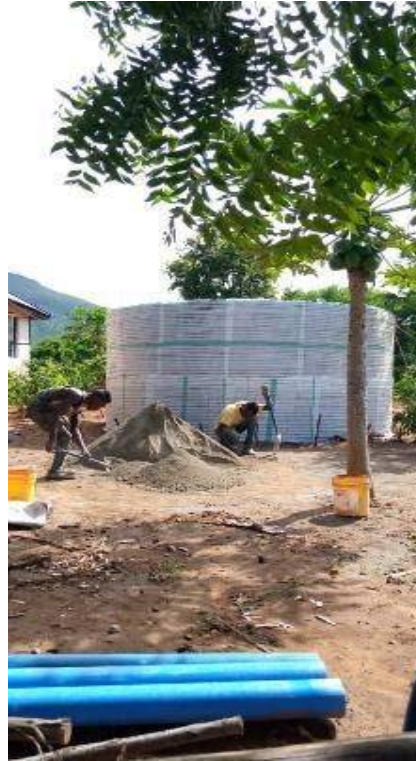
Tank im Rohbau
