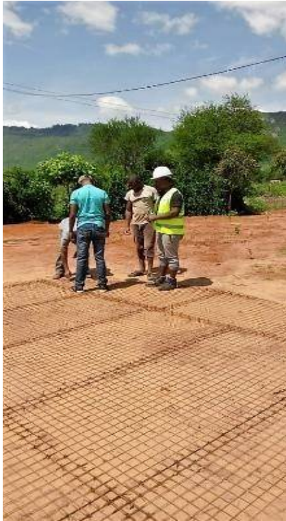
Fundament wird vorbereitet
